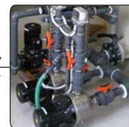
kontrola čerpadel, ventilů a potrubí
