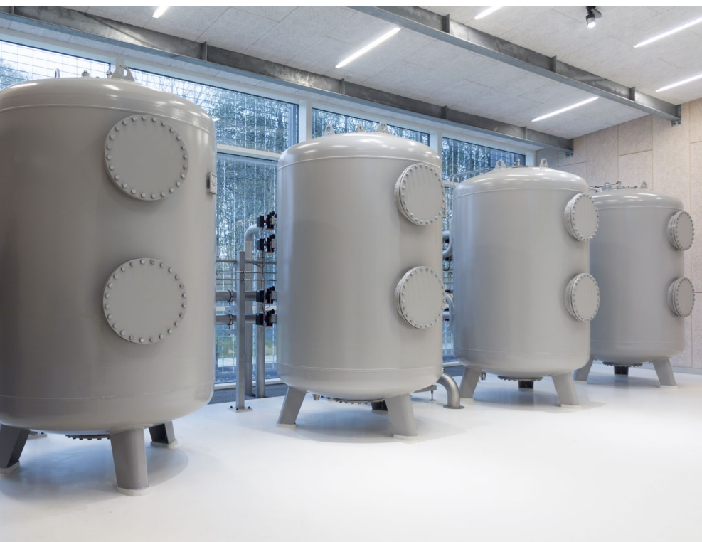
Odstraňování železa, manganu a amonných iontů ve vodárně. Průtok: 2 x 30 m 3 /hod.
