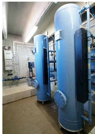
Mnoho zákazníků nemá z různých důvodů možnost napojení na veřejnou vodovodní síť. Pro ně je určeno principiálně stejné technické řešení jako pro velké vodárny. Tlakové filtry typ NSB jsou ideálním řešením pro malé a střední spotřebitele pitné vody.
